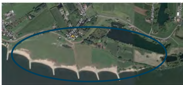
Luchtfoto huidige situatie
